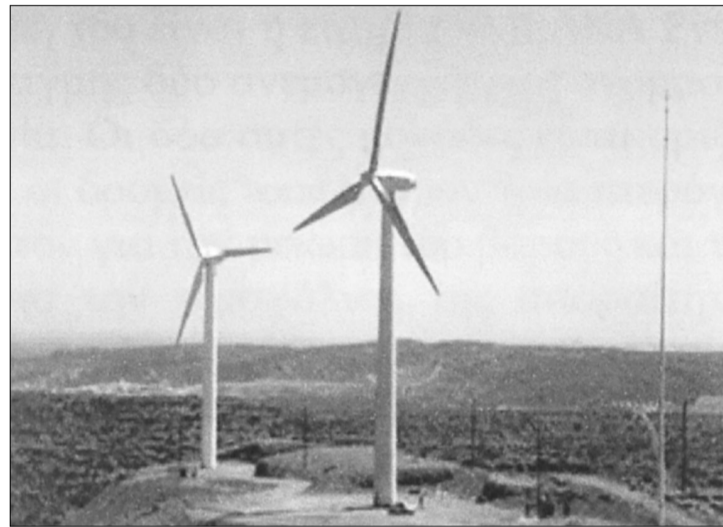
Τυπικό αιολικό πάρκο με δύο ανεμογεννήτριες.
