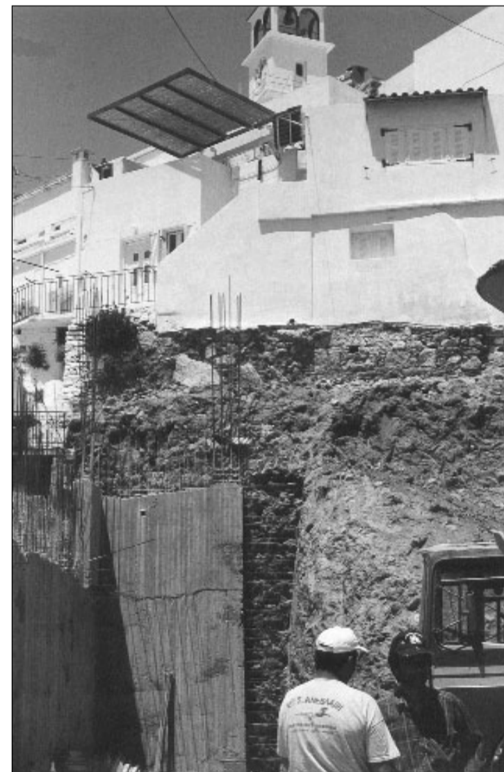
Από τις εργασίες κατασκευής του ξενώνα στην Κομιακή.
